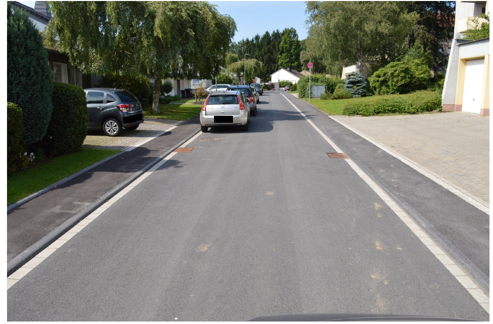
Separationsprinzip Fahrbahn— Gehweg mit 4 cm— Rundbord
