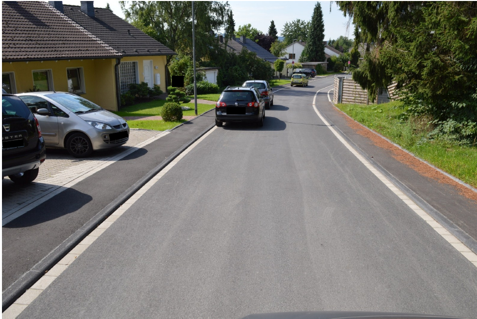
Separationsprinzip Fahrbahn— Gehweg mit 4 cm— Rundbord
