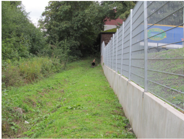
Abb. 2.2: Nördl. Schwelmeverrohrung, Auslauf DN 600 gegen die Fließrichtung
