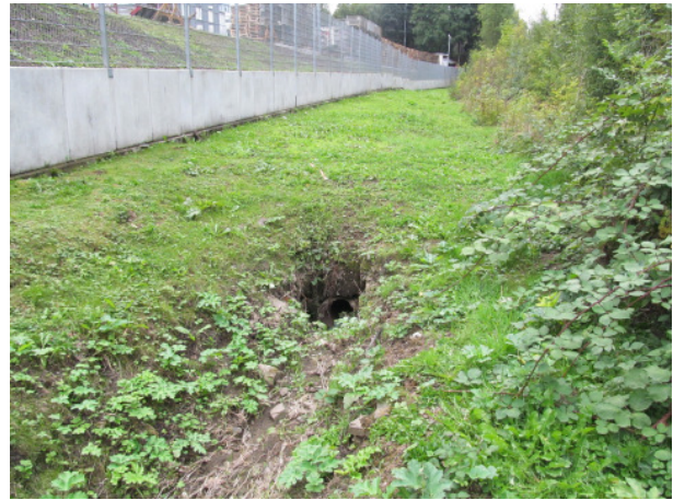
Abb. 2.3: Wiedereintritt in die Verrohrung, DN 400 in Fließrichtung
