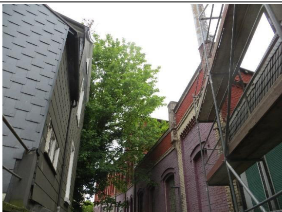
Ansicht südliche Gebäudestrukturen
