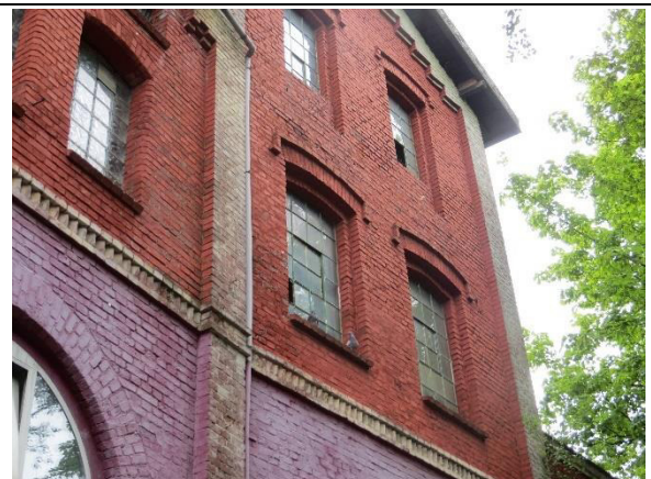
Ansicht südliche Gebäudestrukturen
