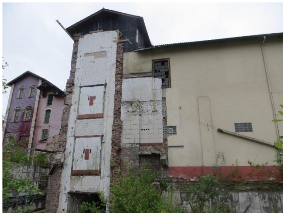
Ansicht südliche Gebäudestrukturen
