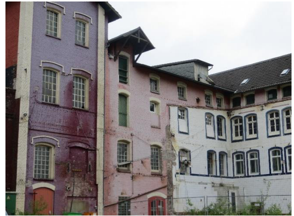
Ansicht südliche Gebäudestrukturen
