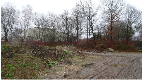
Lagerfläche und Weg im Osten des Friedhofserweiterungsbereiches, Baumbestände am nördlichen Rand zum Gewerbegebiet
