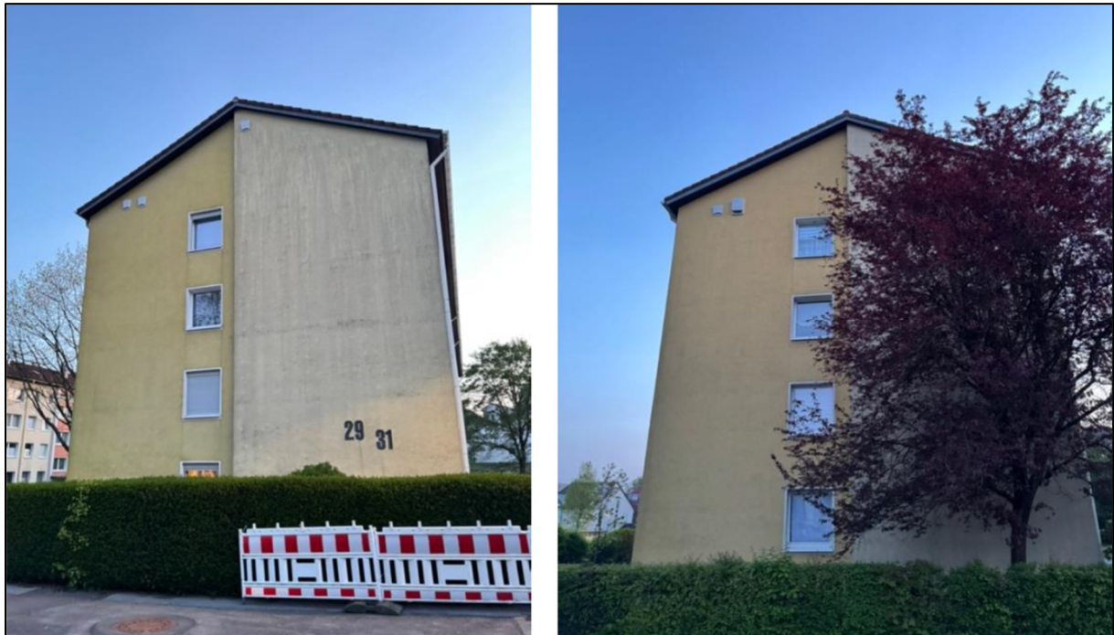
Abb. 4 Installierte Ersatzkästen an den Gebäuden Pastor-Nonne-Str. Nr. 25/27 und Nr. 29/31
