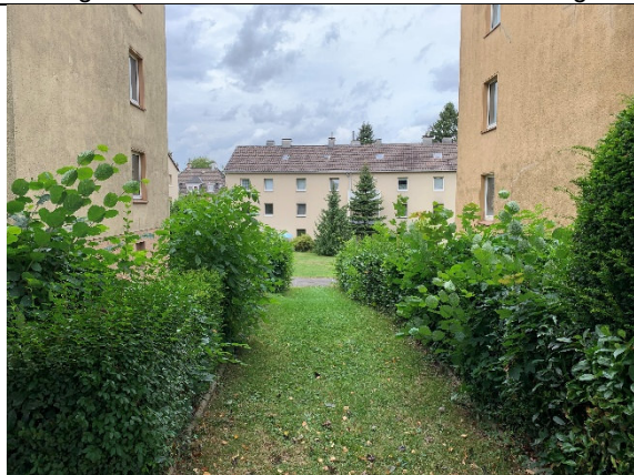
Blick auf Südseite der Bebauung Lindenstrae
