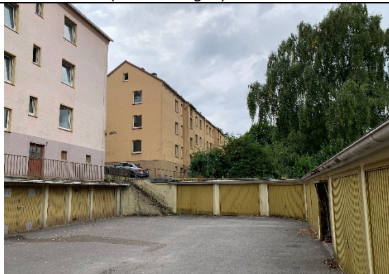
Garagenhof im Ostteil
