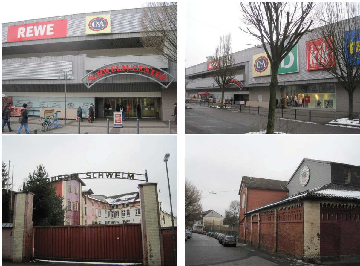
Abbildung 6: Fotos Schwelm-Center/ ehem. Brauereigelände
