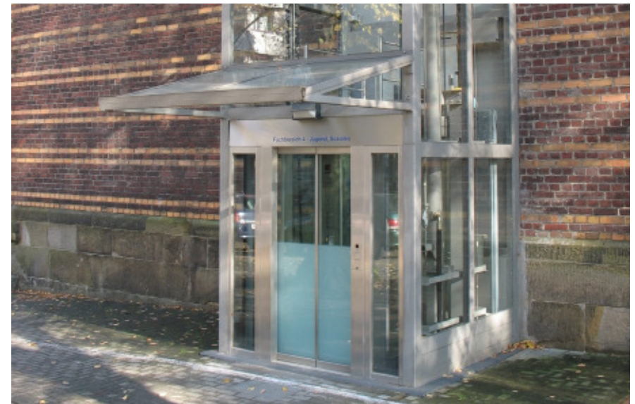
Aufzug am Verwaltungsgebäude III - Moltkestraße
