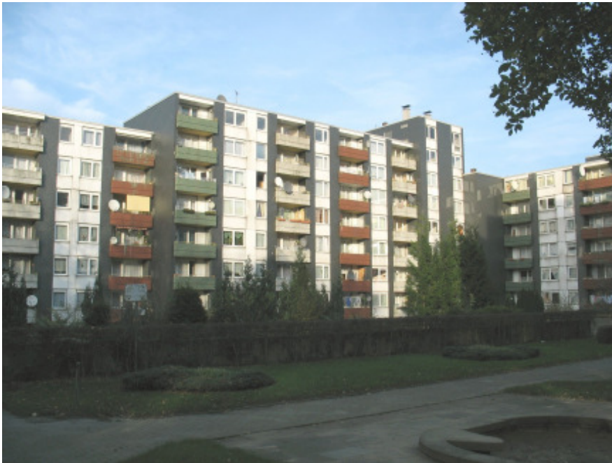
Wohngebäude Kaiserstraße/ Markgrafenstraße
