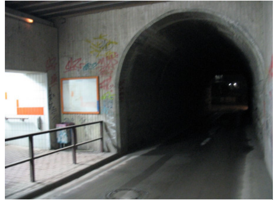
Unterführung am S-Bahn Haltepunkt Schwelm-West
