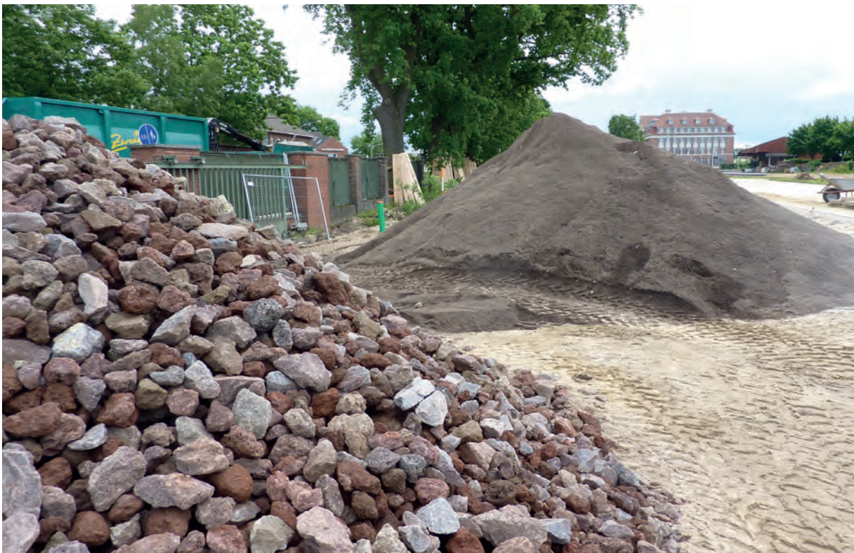
Abbildung 13: Ausgangsmaterialien einer Skeletterde. Im Vordergrund lagert das grobe Material, in das das feinere Substrat (Bildhintergrund) eingespült wird. Hieraus entsteht eine Matrix, die hoch belastbar, aber nicht überverdichtbar ist und somit dauerhaft vegetations- und straßenbautechnischen Ansprüchen genügt.
