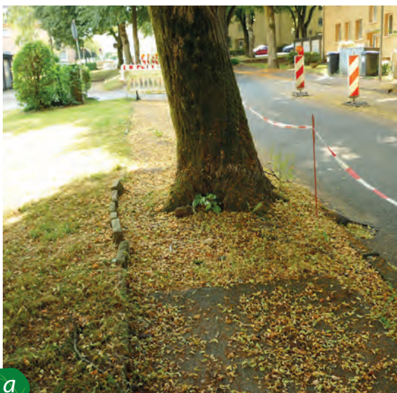
Abbildung 33: Baumstandorte in der Lindenstraße: a) Die Nutzbarkeit des Gehweges ist bei allen im westlichen Abschnitt stehenden Bäumen gleich stark eingeschränkt. b) Hinzukommend haben die dort mit dem Wachstum oberflächennaher Wurzeln einhergehenden Schäden der Baumumfelder zu Absperrmaßnahmen geführt.
