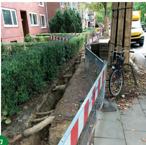
Abbildung 17: Praktischer Baumschutz auf Baustellen in der Stadt Hamburg: a) Bei Erdarbeiten werden statisch relevante Wurzeln nicht durchtrennt, sondern wurzelschonend in Handschachtung freigelegt und bis zur Verfüllung des Grabens vor Austrocknung geschützt. b) Bei unabdingbaren Entnahmen von Wurzeln erfolgt umgehend die fachgerechte Nachversorgung der Wunden, so dass sich an ihnen rasch neue Wurzeln bilden können.
