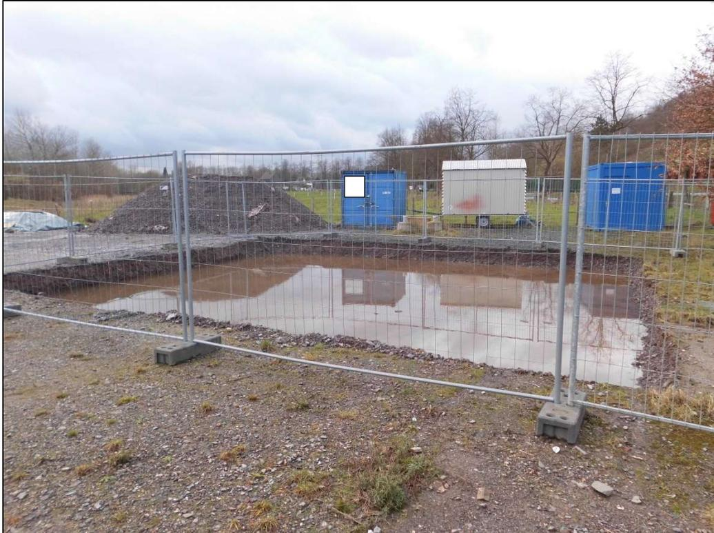
Abbildung 3: Hoher Wasserstand in Baugrube
